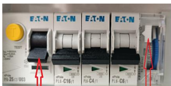
Obr 5. – pojistky a časovač
